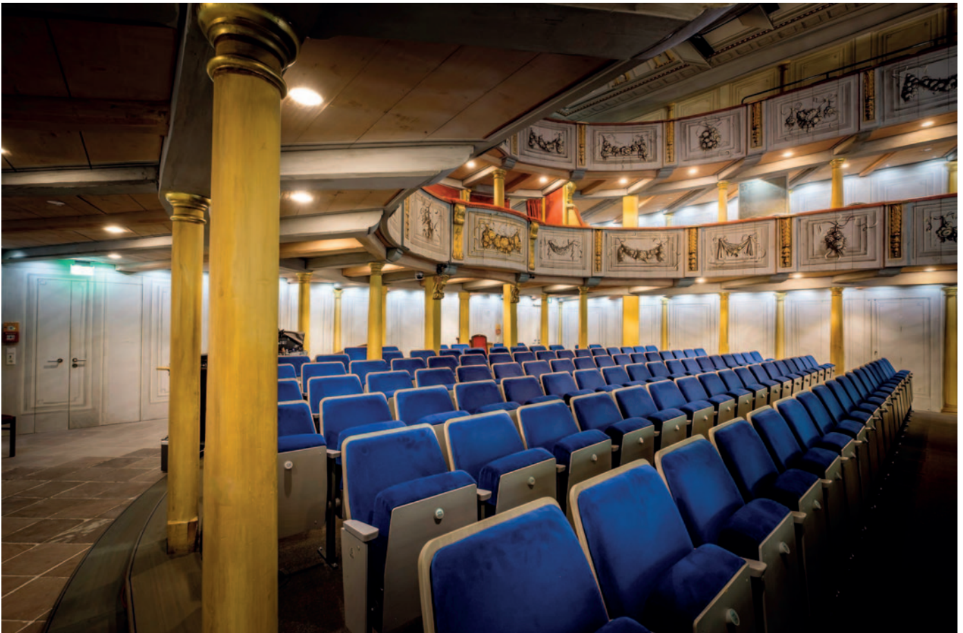
Im historischen Schlosstheater Celle sind die Ansaugöffnungen der TITANUS® Rauchmeldeanlage unauffällig in die Architektur integriert. © WAGNER Group GmbH
